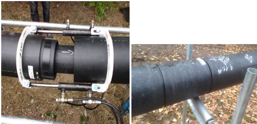
Abb. 1.5 Schritt 4: Fügen der Transportrohr-Langschüsse über dem innen liegenden Kabel im Simofuse-Verfahren® am Test- und Pilotstandort Stade
