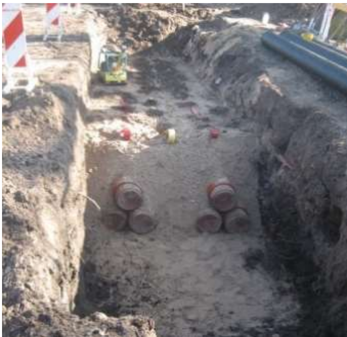
Abb. 10: Beispiel: Schmaltrasse mit Dreiecksanordnung der Leerrohre ©
